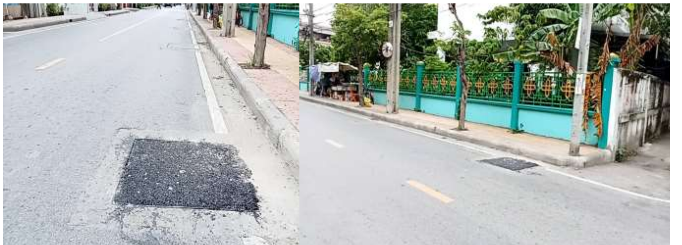
ภาพหลัง ซ่อมแซมฝาท่อ บริเวณถนนทรงธรรม - หน้าโรงเรียนเทศบาลวัดทรงธรรม
