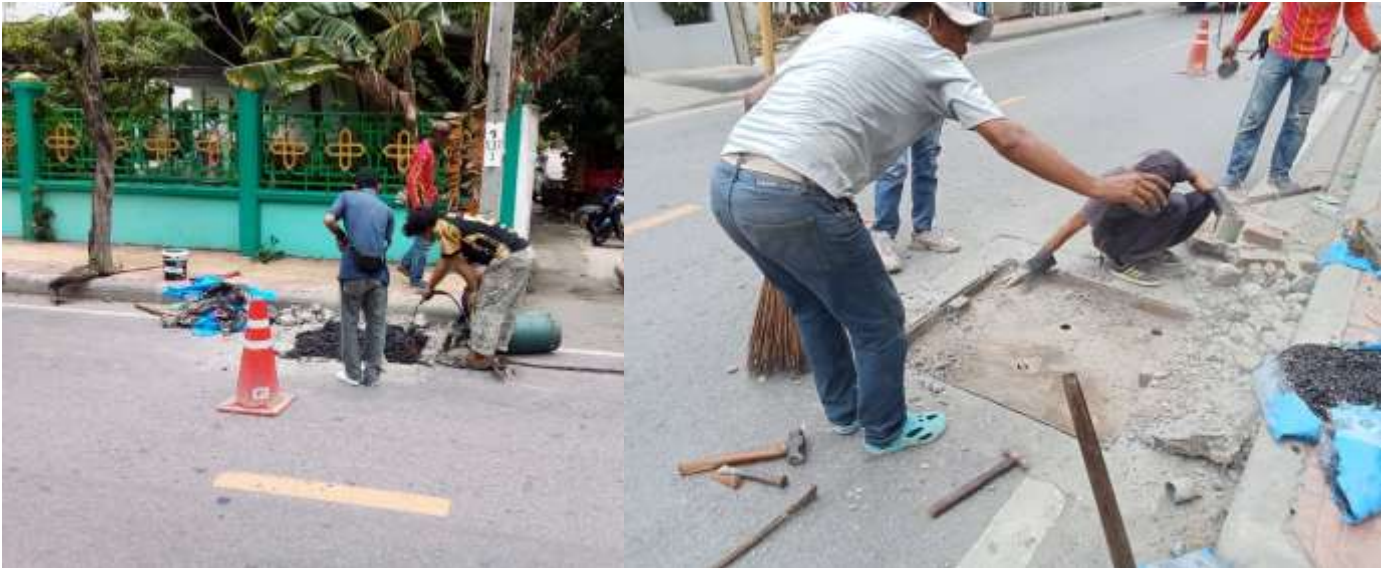
ภาพก่อน ซ่อมแซมฝาท่อ บริเวณถนนทรงธรรม - หน้าโรงเรียนเทศบาลวัดทรงธรรม
